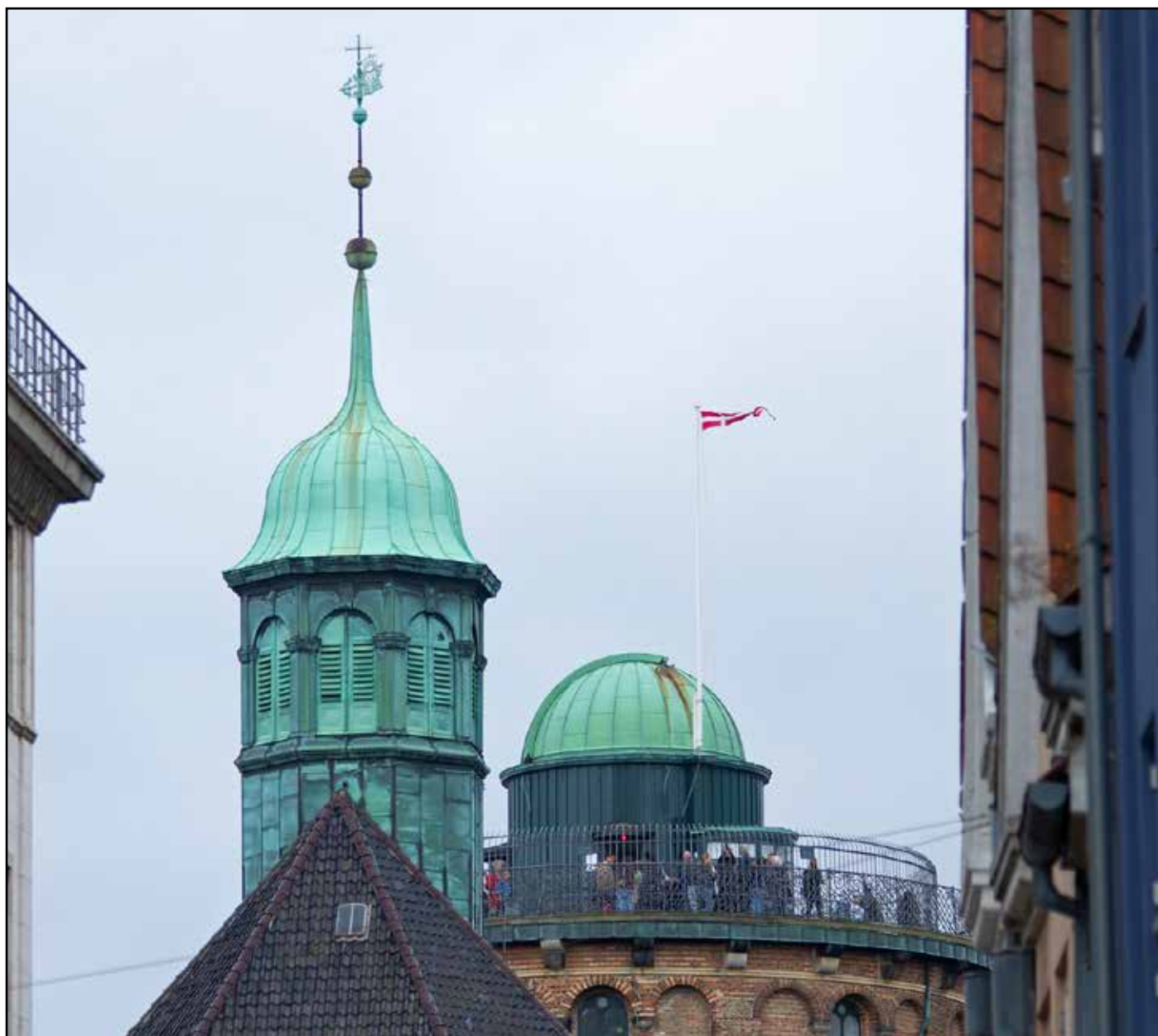
Le sommet et la coupole de Rundetårn vus d'une rue proche.
