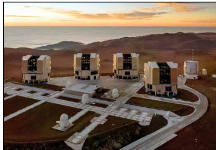
Le VLT avec ses 4 télescopes de 8,5m et 4 télescopes de 1,8m. Le bâtiment au centre est le laboratoire optique abritant les instruments et les chemins optiques lorsque le VLT est utilisé en mode interférométrie - Source Wikipedia.
